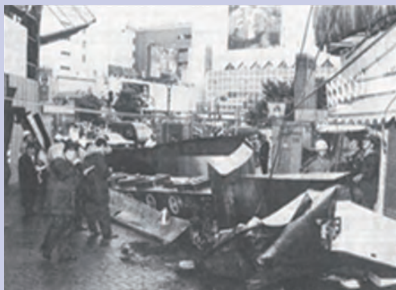
台風で落下した時の様子
